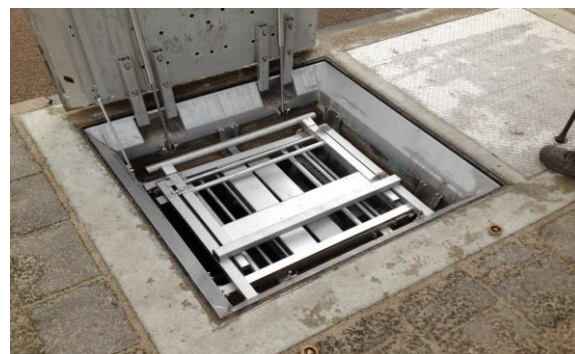
Beispiel: Geländer in Abdeckung eingeklappt
