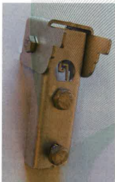
Bild 4: Endsperre Typ A und Typ B, Typ: Endanschlag H-50
